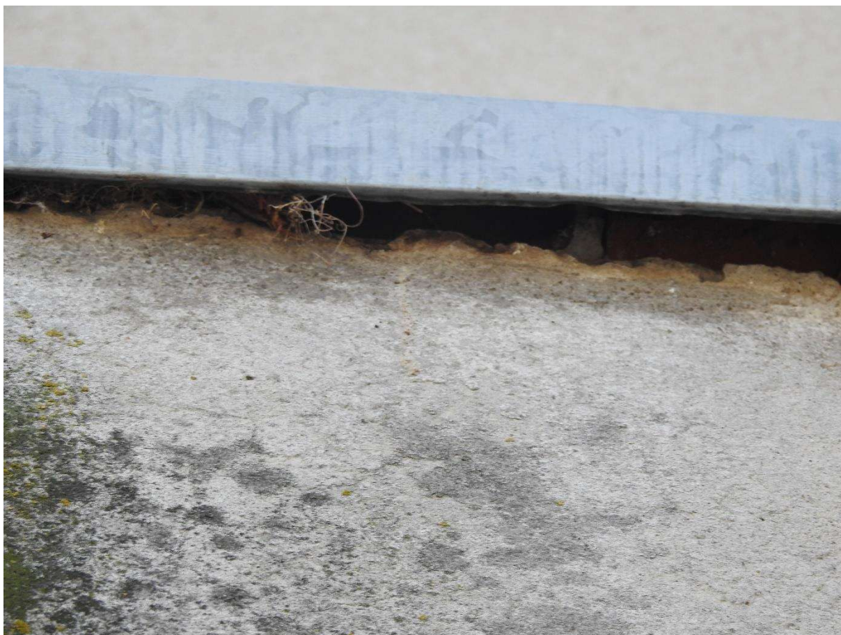
Fot. 2 Fragment obróbki blacharskiej z widocznym materiałem gniazdowym wróbla domowego.
