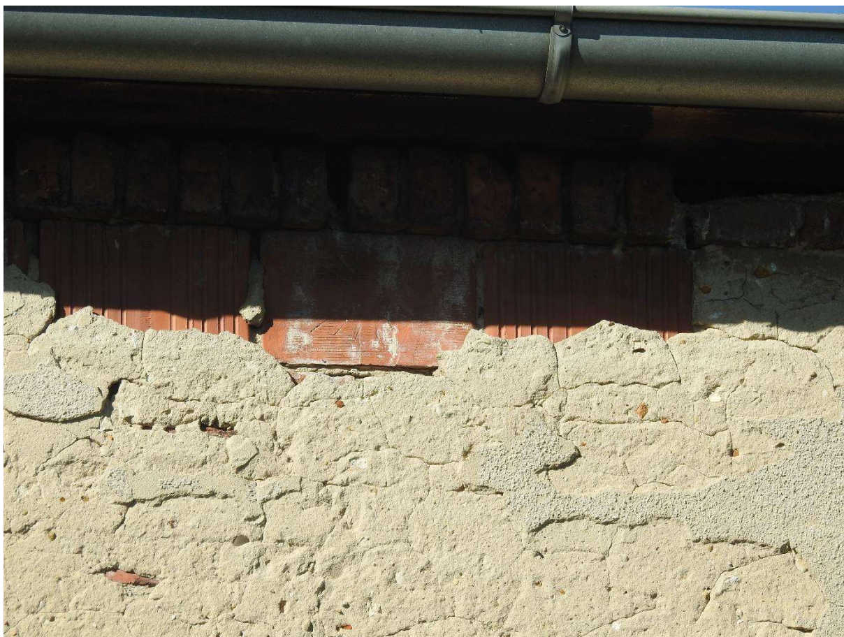
Fot. 8 Szczelina pod dachem wschodniej elewacji budynku północnego (na Ryc. 1 oznaczona czerwoną linią).
